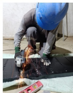
Corte y adecuación de estructuras
