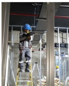
Montaje de bandejas portacables
