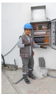
Montaje y revisión de tablero
