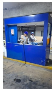
Acondicionamiento de módulo y acabados
