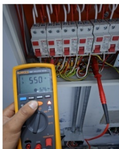
Pruebas de aislamiento eléctrico
