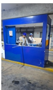
Acondicionamiento de módulo y acabados
