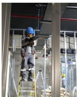
Montaje de bandejas portacables
