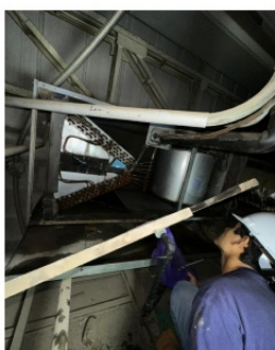
Instalación y mantenimiento en altura
