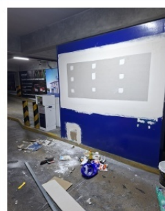
Trabajos de pintura y renovación
