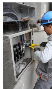
Mantenimiento de instalaciones eléctricas
