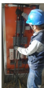
Intervención técnica de tablero
